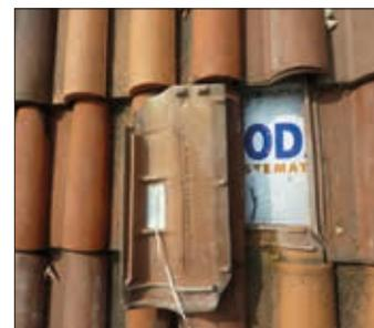
Foto 2 - Posa delle sonde di temperatura sulla copertura con alluminio
